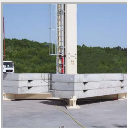
Опорная крестовина, нагруженная балластом (1)
